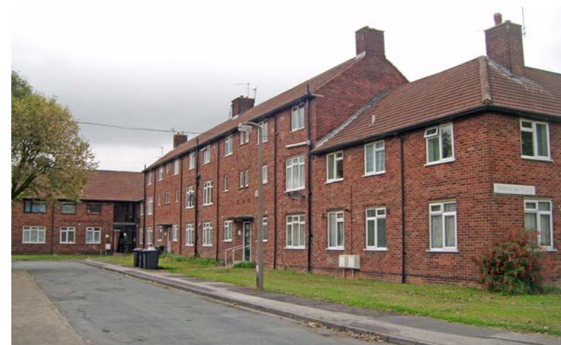
Springfield Close flats
